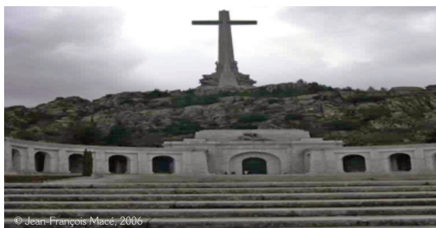
● Fig.2 : vue extérieure du monument du Valle de los Caídos
